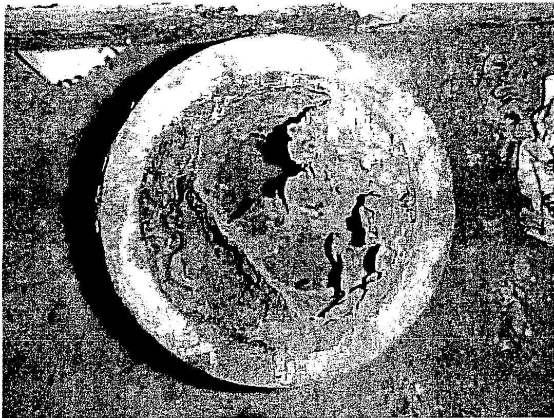
Ejemplo de cañería con grado de incrustación elevado.
