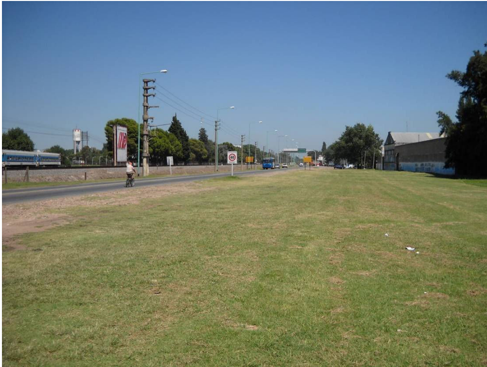
Fotografía 1.1. Vista del sector de emplazamiento de la obra, al Norte del ferrocarril Vista hacia el Oeste
