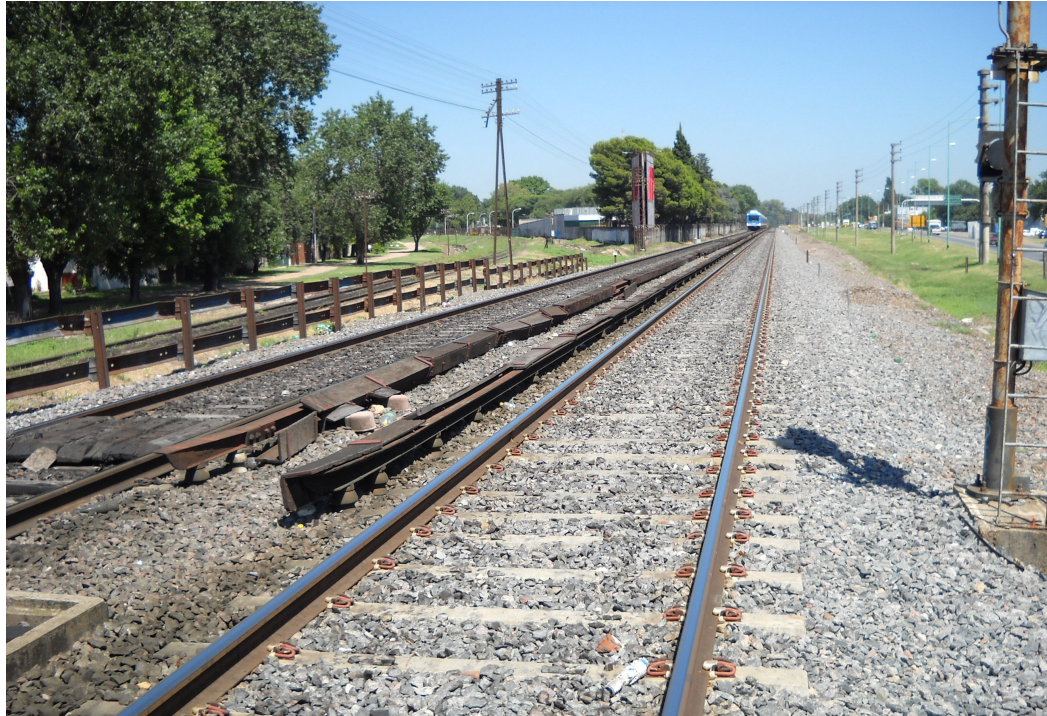
Fotografía 1.3. Vista del sector de emplazamiento de la obra, al Sur del ferrocarril Vista hacia el Oeste
